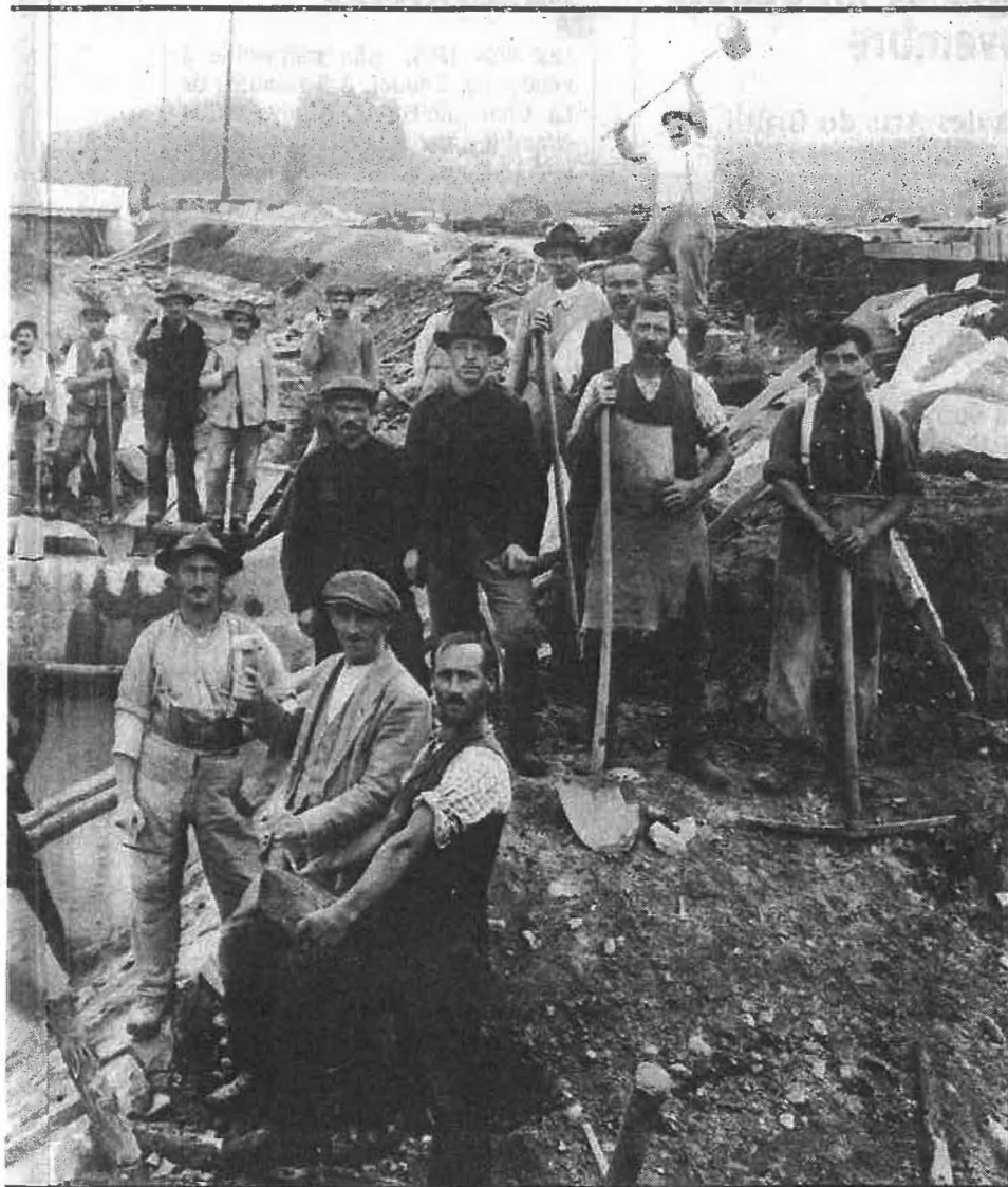
Travaux de correction d'un cours d'eau dans l'Oberland zurichois. (Photographe inconnu)
